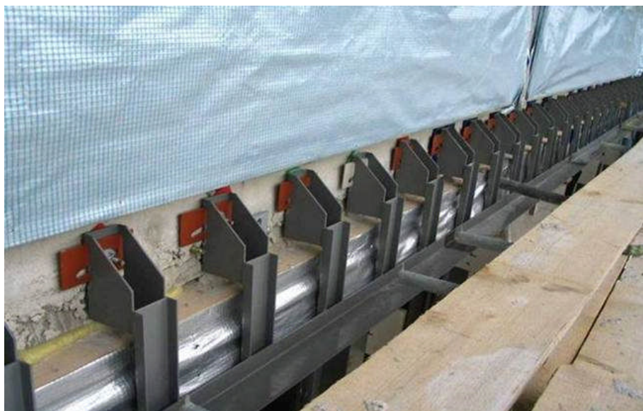
Figuur 5, Metselwerkondersteuning doorbreekt de isolatielaag.
